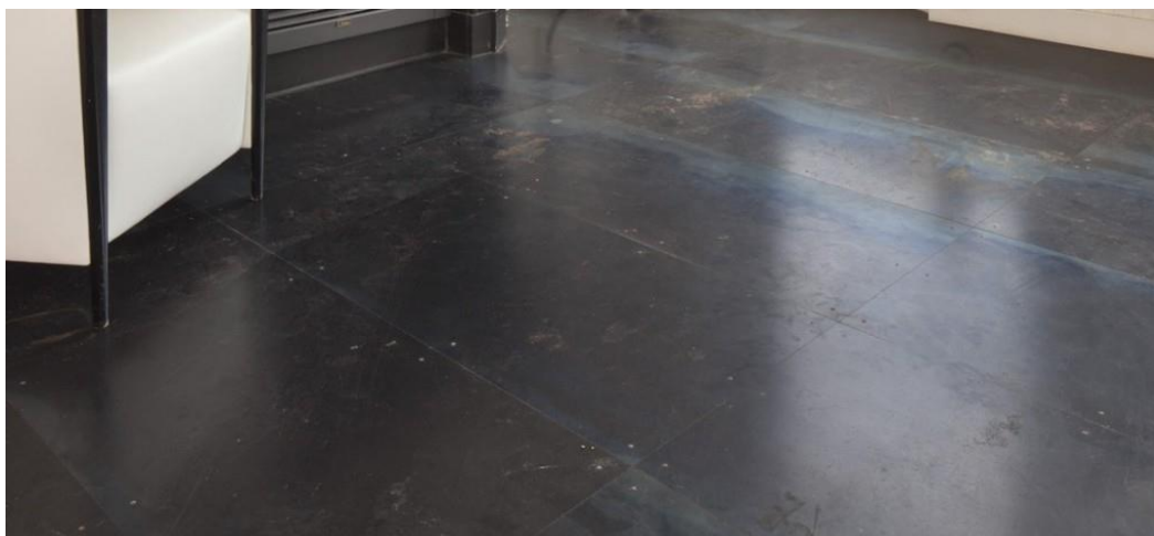
Foto: Voorziening van aan elkaar gelaste metaalplaten.
